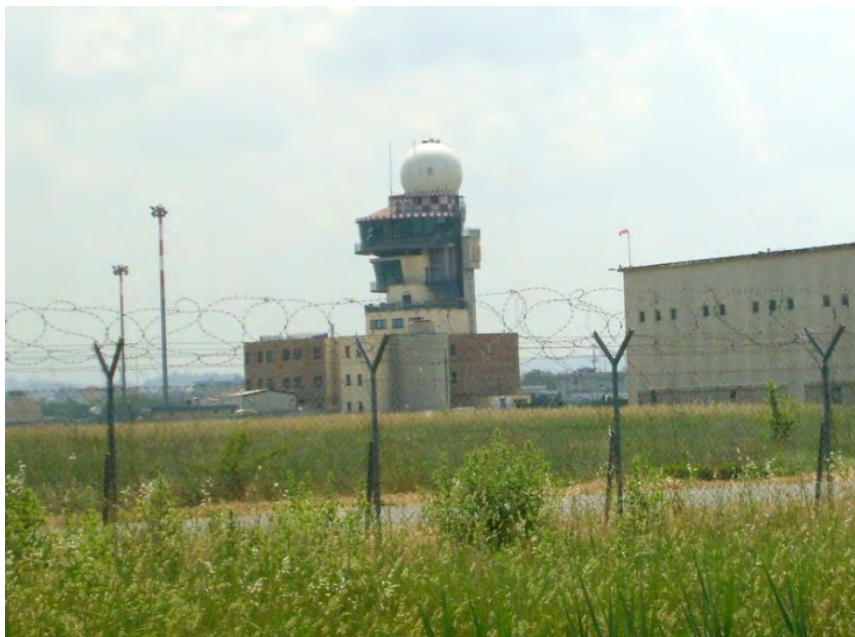
Fig. 1 - Radar per il controllo del traffico aereo ATCR 33S dell'aeroporto di Firenze-Peretola
