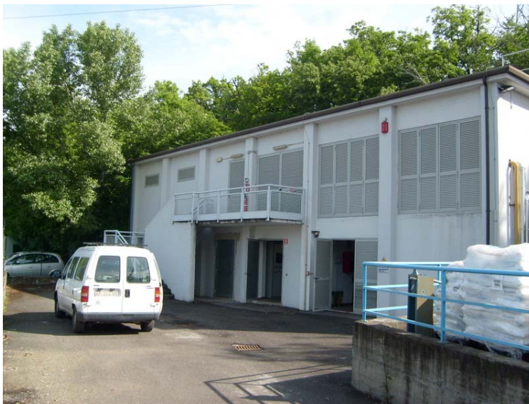
Figura 33: Locale trasformatori e dell'impianto di cogenerazione (P.O. Desenzano)
